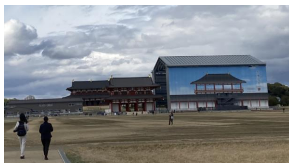
着手する東楼整備工事の実物大のイメージ (国営飛鳥歴史公園事務所平城分室 出口義治)
