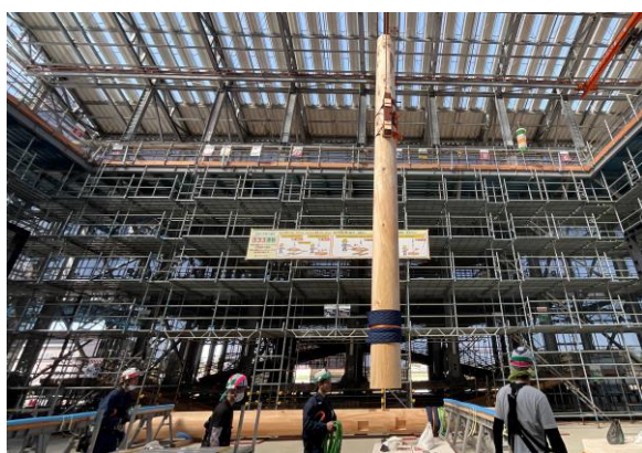
写真1:側柱の建て込み状況
