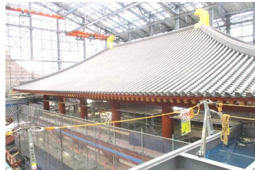
令和7年3月現在 東楼素屋根内
