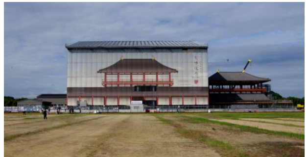
スライド作業 1 日目終了時点 (令和7年9月24日)
