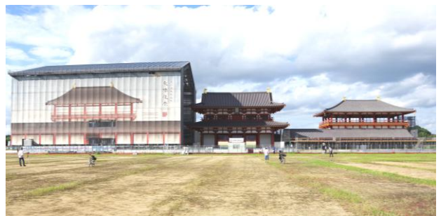
スライド作業完了 (令和7年9月29日)
