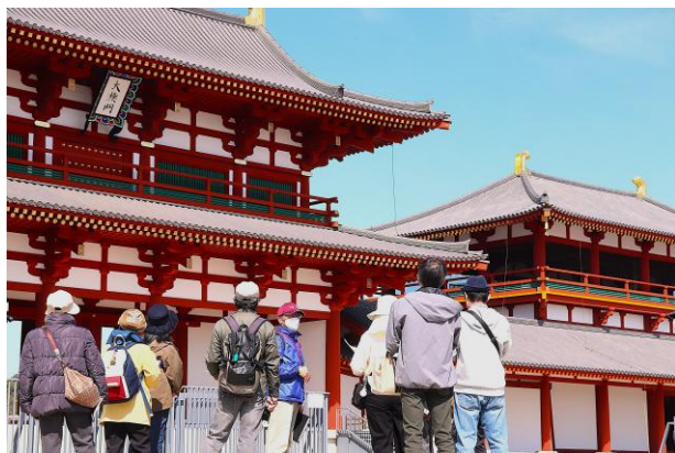
大極門南面から、右が東楼(管理センター提供)
