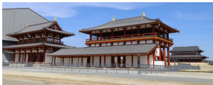
完成した第一次大極殿院東楼
